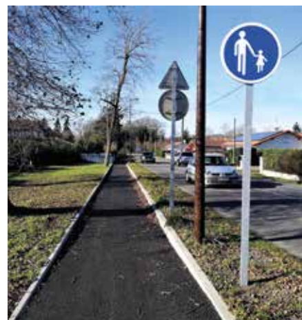
L'aménagement de la voie piétonne route de Saint Geours.
