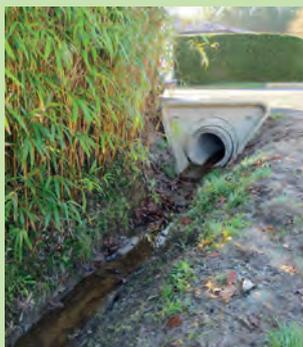
Les fossés sont des aménagements artificiels destinés à l'écoulement des eaux.
